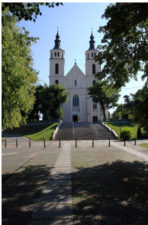
Kościół pw. Przemienienia Pańskiego w Piątницы Poduchownej
