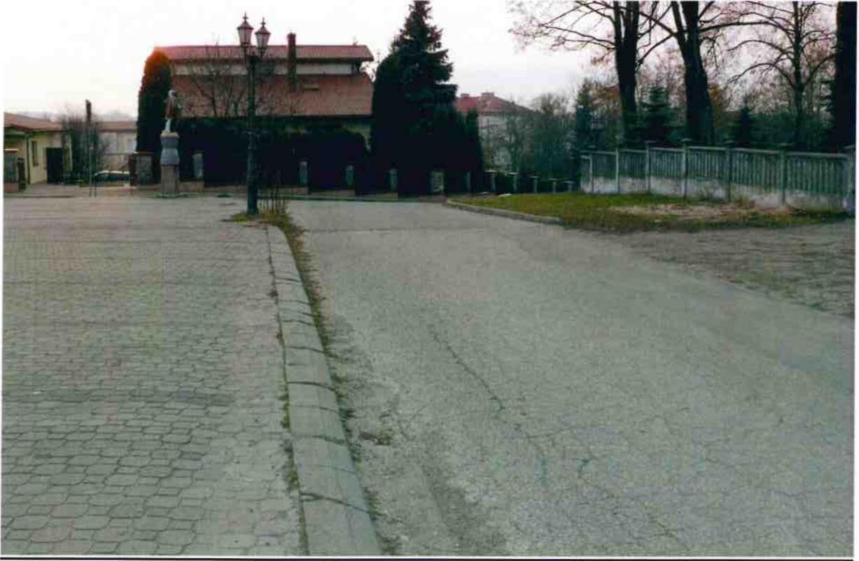
fot.1 ul. Cmentarna w km 0 + 016
