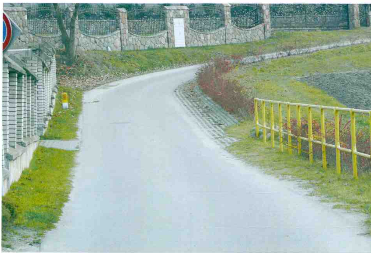
fot.3 ul. Cmentarna w km 0 + 383
